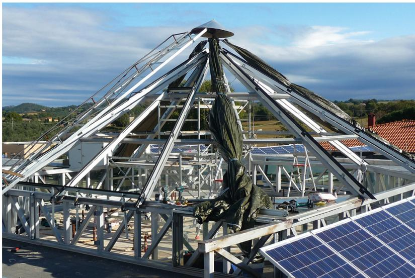
Fig. 9: il lucernaio liberato dai vecchi vetri, è già pronto per ricevere la nuova struttura isolante.
